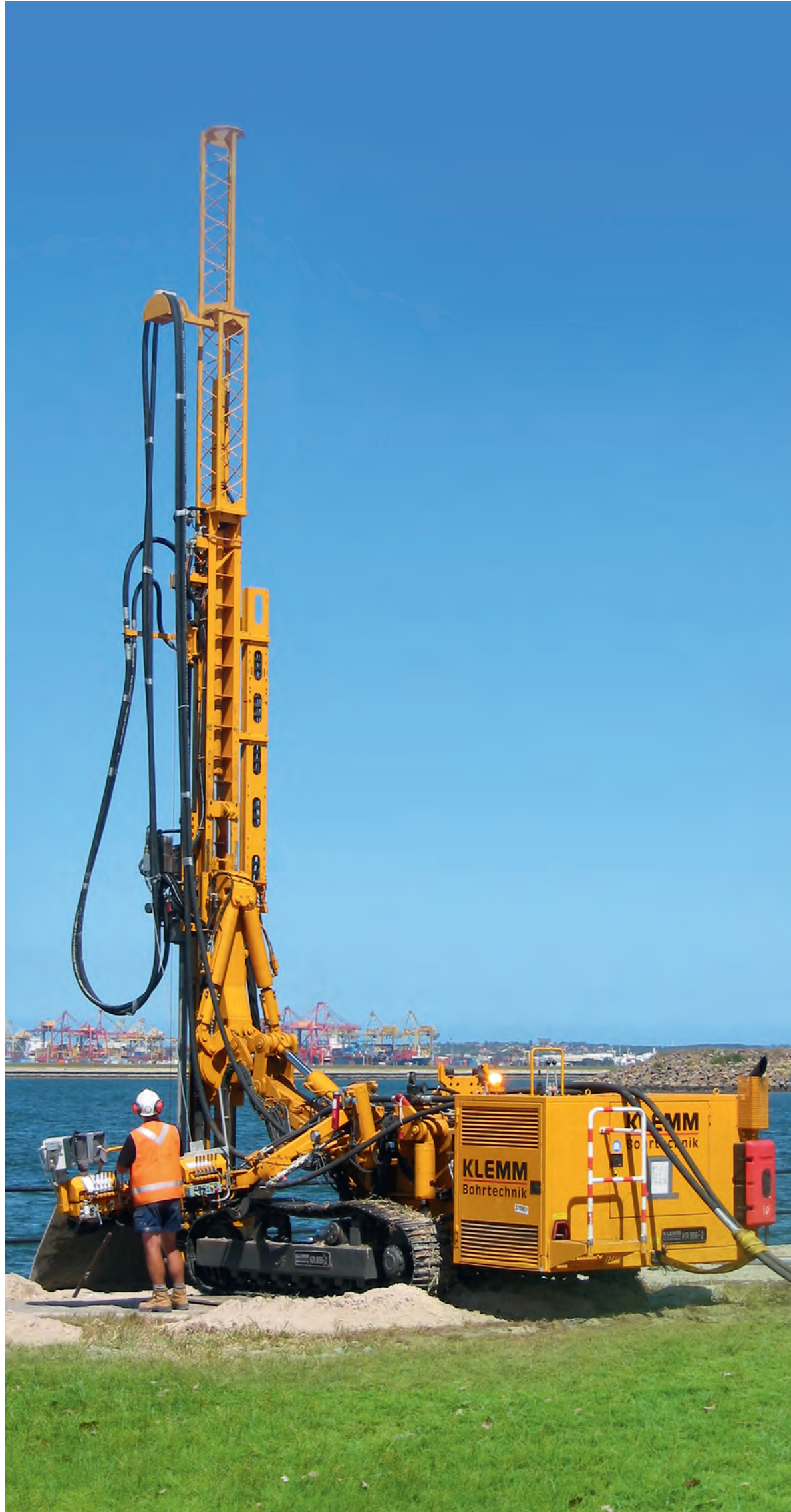
Hochdruckinjektionen High-pressure injections
