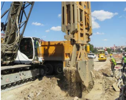
MC 64 mit DHG-V, Verbauwand, Türkei MC 64 with DHG-V, Retaining wall, Turkey
