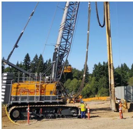
BFV 75 Flying Vibro, Rüttelstopfverdichtung, USA BFV 75 Flying vibro, Vibro displacement , USA
