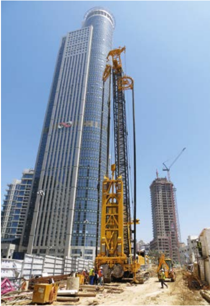
MC 96 BC 35, Schlitzwand, Ägypten MC 96 BC 35, Diaphragm wall, Egypt
