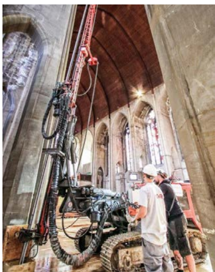
KLEMM KR 801-3FS Einphasen-HDI, Belgien KLEMM KR 801-3FS One-phase jet grouting, Belgium
