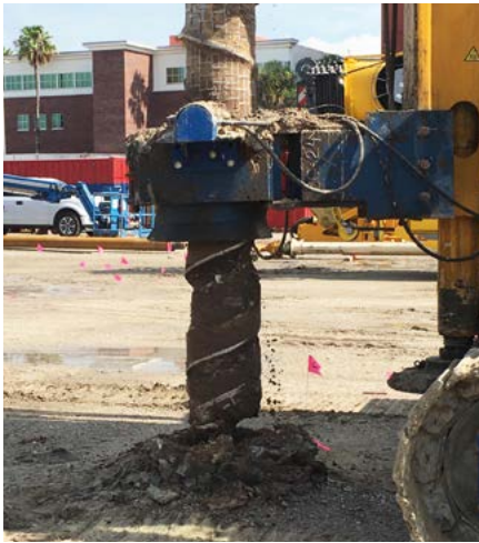
BG 24 H, FDP Verdrängerpfähle, USA BG 24 H, FDP Displacement piles, USA
