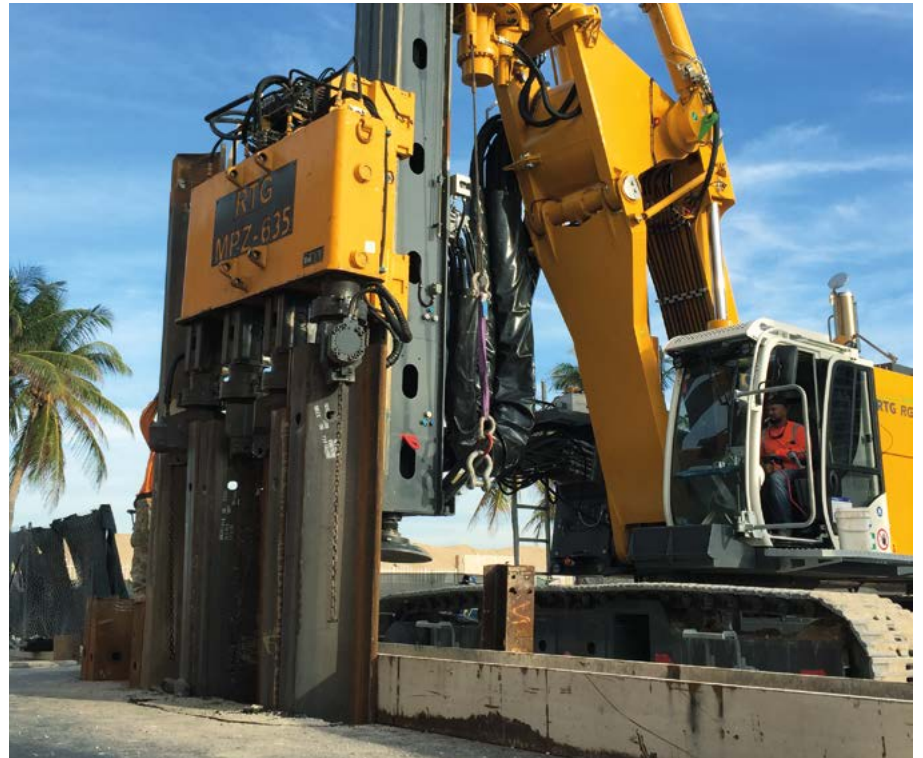
RG 25 S, Spundwand Pressen, USA RG 25 S, Sheet pile pressing, USA
