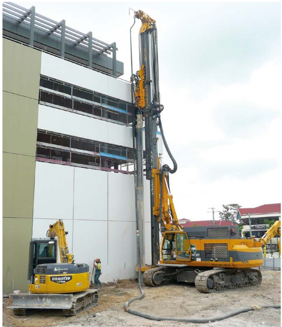
RG 19 T, Pfahlwand, Australien RG 19 T, Secant pile wall, Australia
