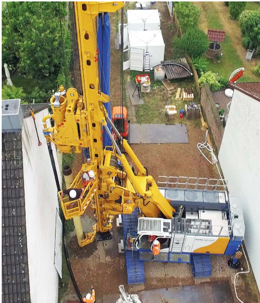
BG 28 H, FDP Lost Bit Gründungspfähle, Deutschland BG 28 H, FDP Lost Bit, Foundation piles, Germany
