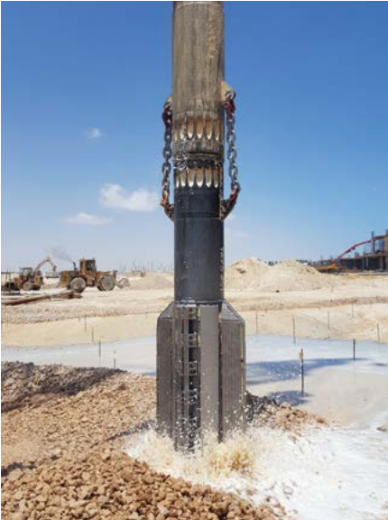
TR 75, Tiefenrüttler, Ägypten TR 75, Depth vibrator, Egypt
