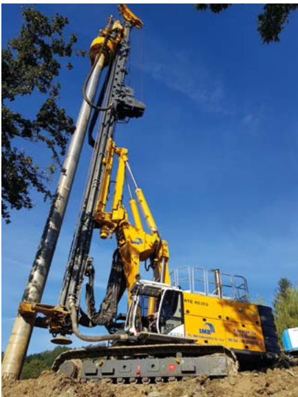
RG 25 S, Pfahlwand, Polen RG 25 S, Secant pile wall, Poland
